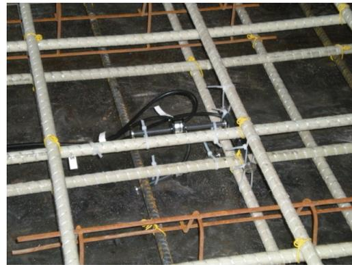
b.) HS-SCC GFRP VWSG Arrangement
